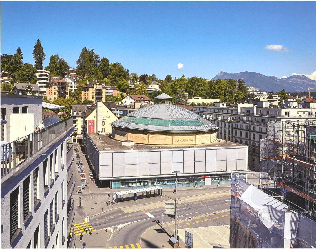
In das Gebäude des Bourbaki-Panoramas in Luzern wurde Mitte der 1920er Jahre eine Garage eingebaut. Noch bis Mitte der 1990er Jahre wurden dort Autos parkiert. Danach wurde die ehemalige Parkette in ein Café umfunktioniert, die Drehscheibe konnte restauriert und funktionsfähig erhalten bleiben. Fotos Dirk Weiss
