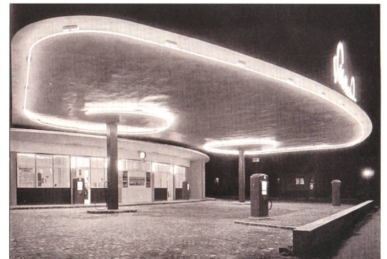
Suter+Suter, Schlotterbeck-Tankstelle, Zürich, Badenerstrasse 415, 1949 (nicht erhalten)
