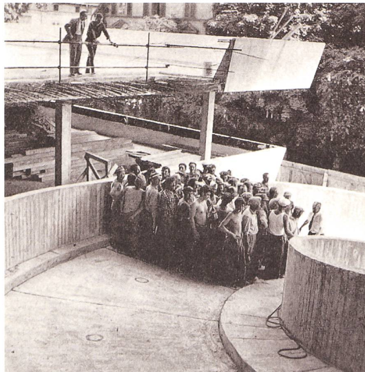
Von der EMPA überwachte Belastungsprobe mit 4000 kg. Betrachtet man die Gesichter der Arbeiter, scheint das durchaus Spass gemacht zu haben. Schweizerische Bauzeitung 83, 1965, Heft 50, S.929
