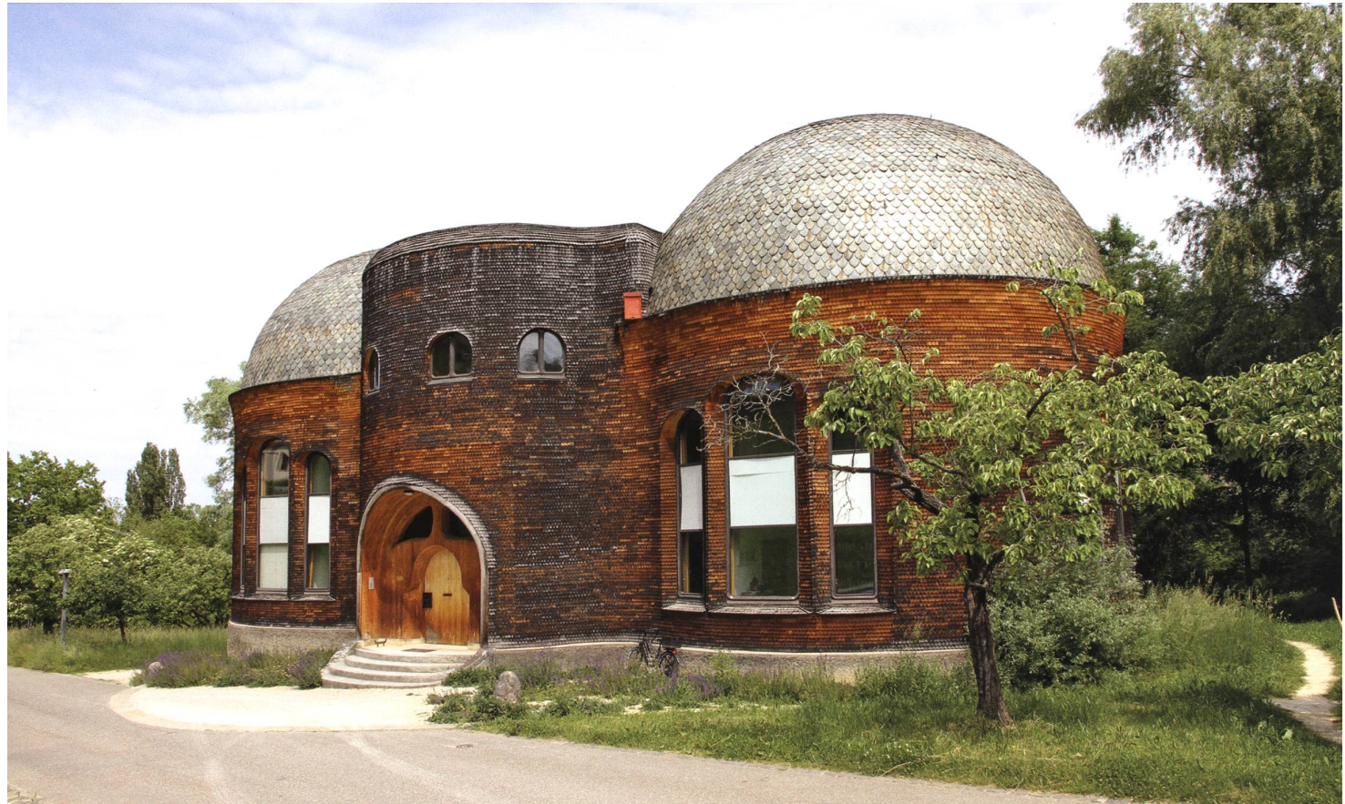
Glashaus (Rudolf Steiner, 1914). Der Holzbau mit seinen beiden schiefergedeckten Kuppeln erinnert in Formensprache und Materialität an das erste Goetheanum von 1913. Foto Michael Leuenberger
