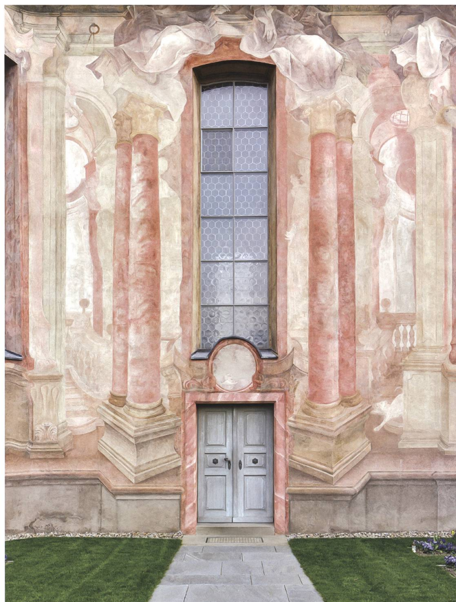
Kloster Fahr Im Limmattal, kunstvolle illusionistische Kirchhofmalerei der Gebrüder Torricelli von 1746/47. Zustand nach der Restaurierung von 2017. © Kantonale Denkmalpflege Aargau, Foto Ralph Feiner
