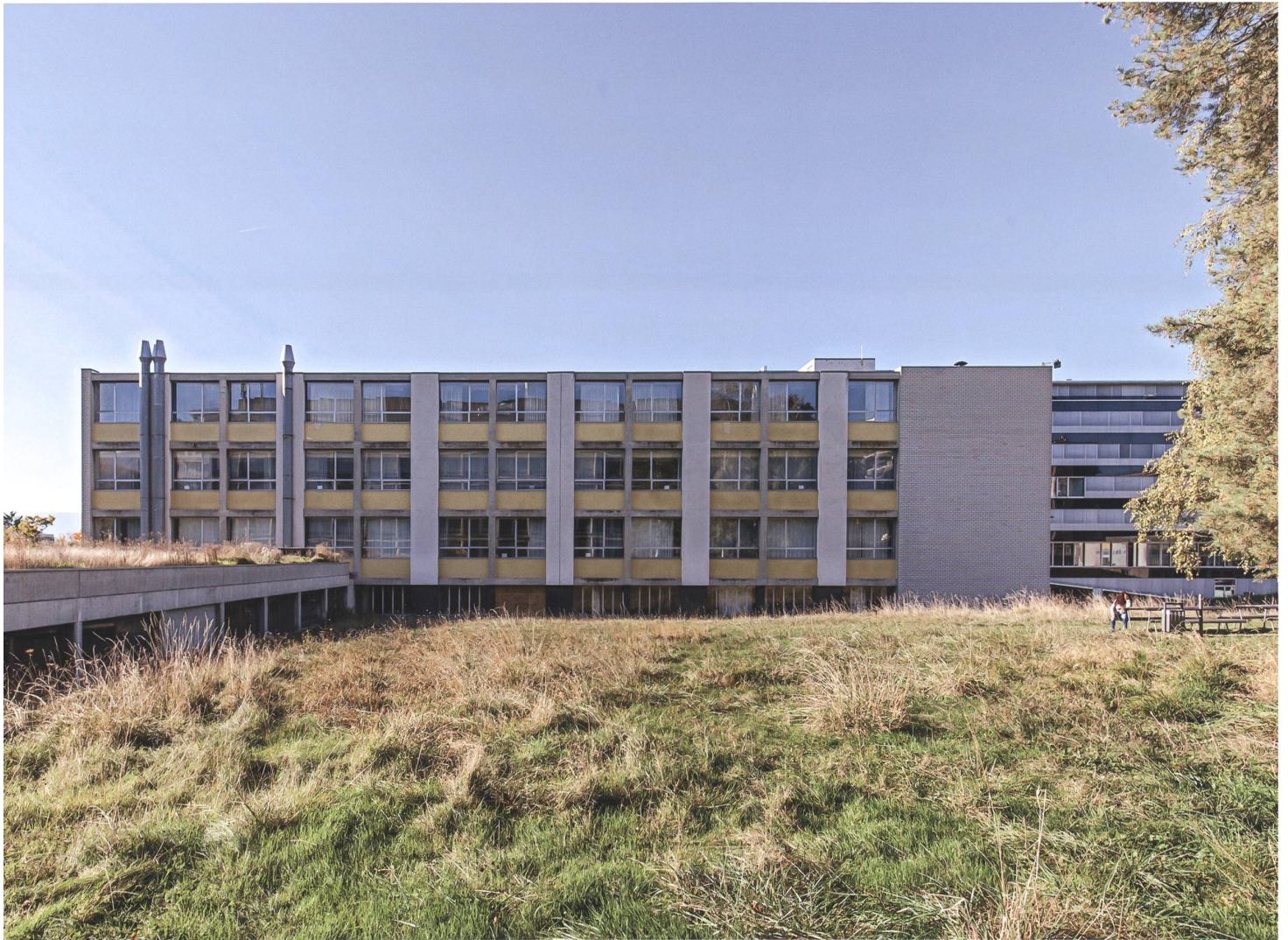
Le bâtiment C et sa façade maçonnée polychrome. Photo Michael Peuckert
