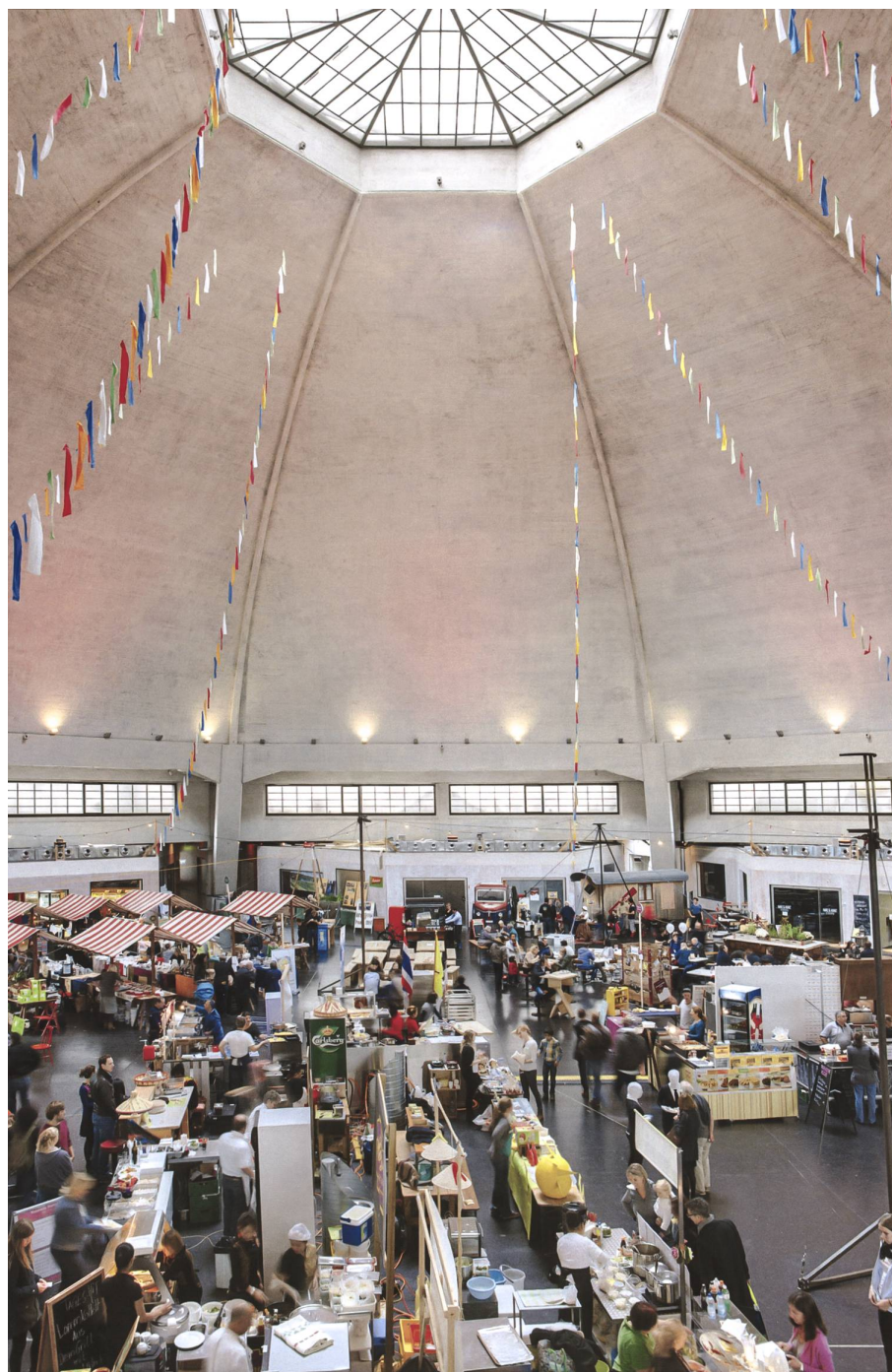
Die Markthalle in Basel wurde durch eine sorgfältige Umnutzung zu einem modernen und attraktiven Gastro- und Wochenmarkort umgestaltet. Foto Martin Zeller, © baubüro in situ AG
