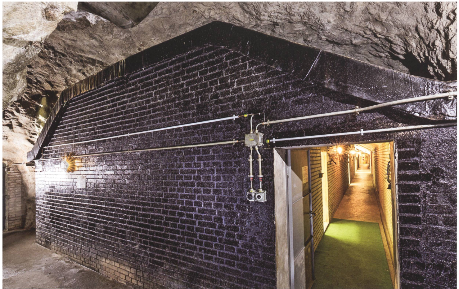
Die Backsteinwände des Kommandopostens der Gebirgsbrigade 9 in Selgis sind mit Flüssig-asphalt überzogen. Foto Michael Peuckert
