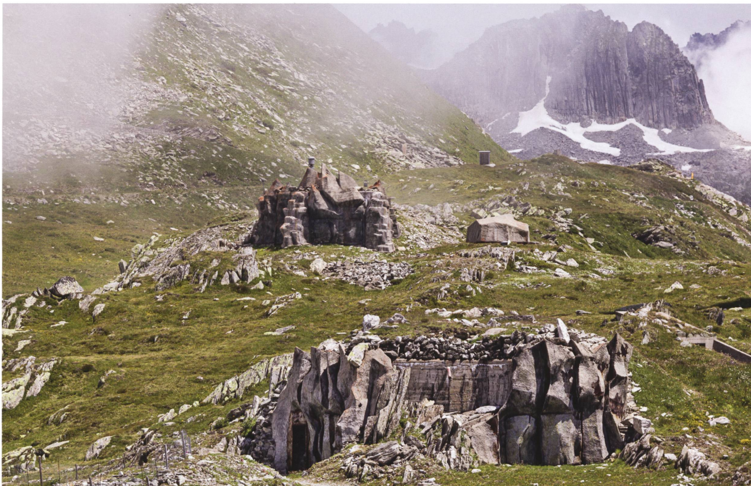
Das Artillerieswerk Güttsch bei Andermatt UR war im Zweiten Weltkrieg die höchstgelegene Festung Europas auf 2300 m ü. M. Für die wintersichere Erschliessung wurde 1941 die Luftseilbahn von Göschenen gebaut; deren Bergstation hat einen direkten unterirdischen Zugang zum Werk. Heute befindet sich auf dem Güttsch eine der wichtigen hochalpinen Wetterstationen. Foto Michael Peuckert
