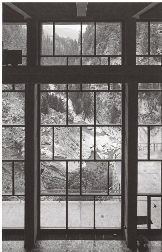
Die Zentrale Ova Spin der Engadiner Kraftwerke AG (1970). Das enge Tal und die Unmöglichkeit, im Nationalpark grosse und frei stehende Bauten zu errichten, hatten zur Folge, dass Stausee, Zentralengebäude, Seeüberlauf und die gewaltigen Fundamente zu einem einzigen Gebäude verschmolzen wurden. Foto Christian Kerez
