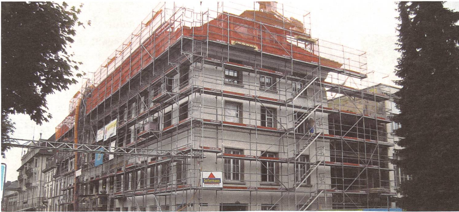
Olten, Amthausquai: Der neue Hauptsitz der ABS will dem Gedanken der 2000-Watt-Gesellschaft folgen und soll die Zertifizierung Minergie-P eco erreichen (Bezug November 2009).
