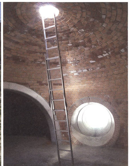
Der Kuppelkeller vor seiner Wiederbedeckung. Darüber wurde das «Humuszentrum»-Haus gebaut (siehe Titelbild).
