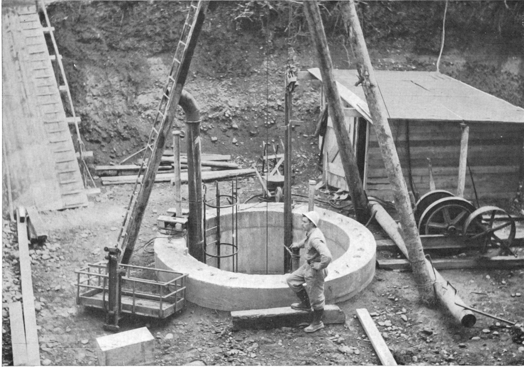
Baugrube für das Pumpwerkegebäude mit fertiggestelltem Fassungschacht
