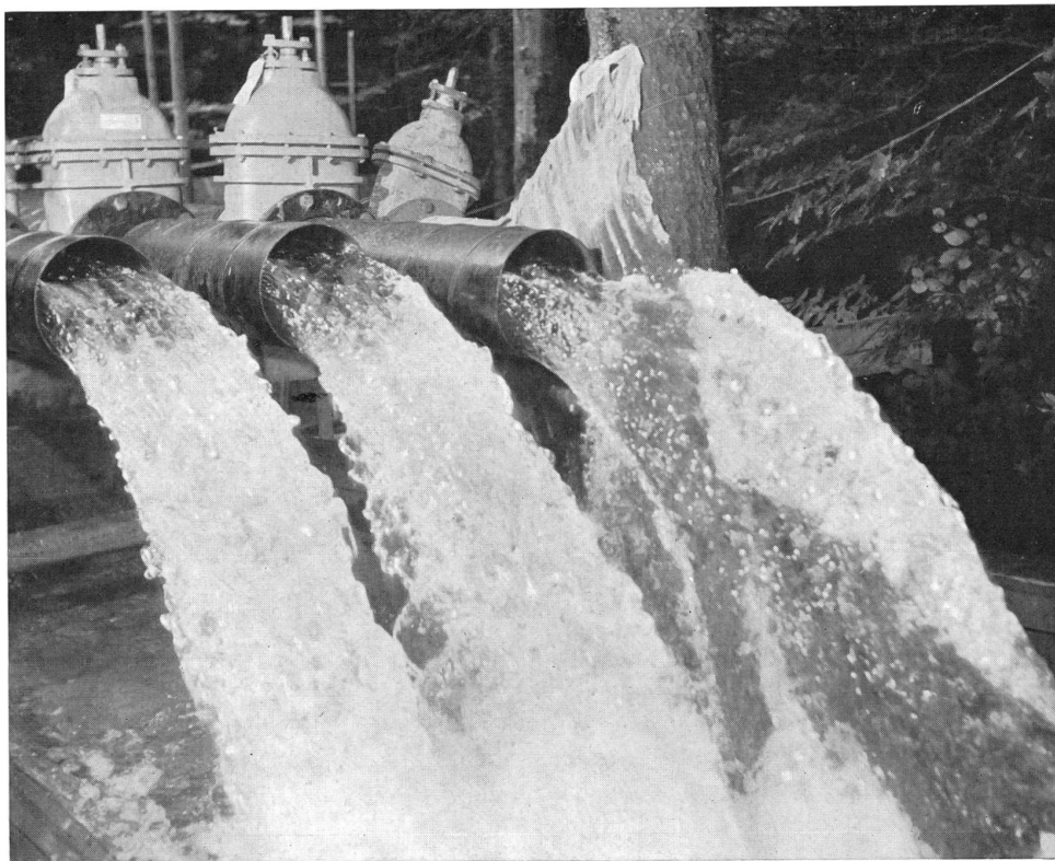
Pumpversuch mit 30 000 Minutenlitern Wasserentnahme, 15. Oktober 1958
