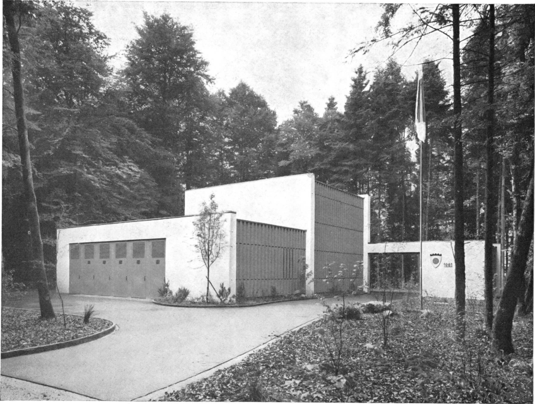
Das Gebäude des Grundwasserpumpwerkes Hard II, ein durch seine einfache, klare Form sich auszeichnender Zweckbau
