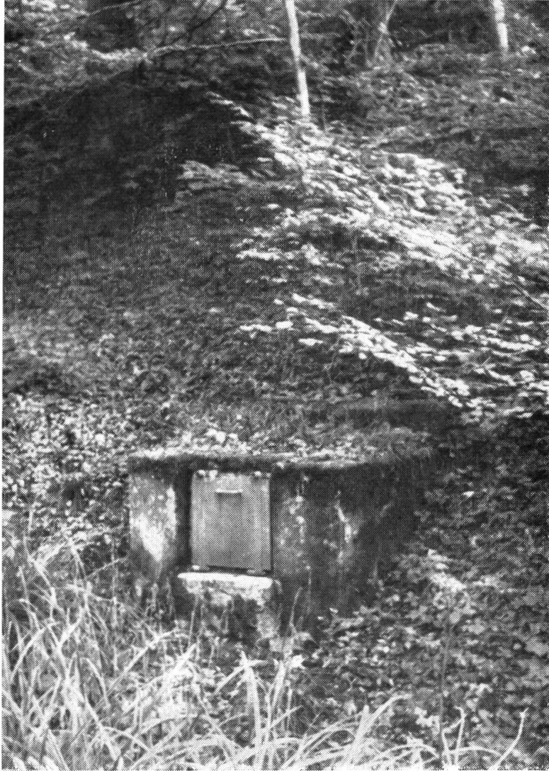
Sammelschacht Nr. 8 (siehe auch Situationsplan Nr. 2) Diesem Schacht wird Wasser aus zwei Quellfassungen zugeleitet
