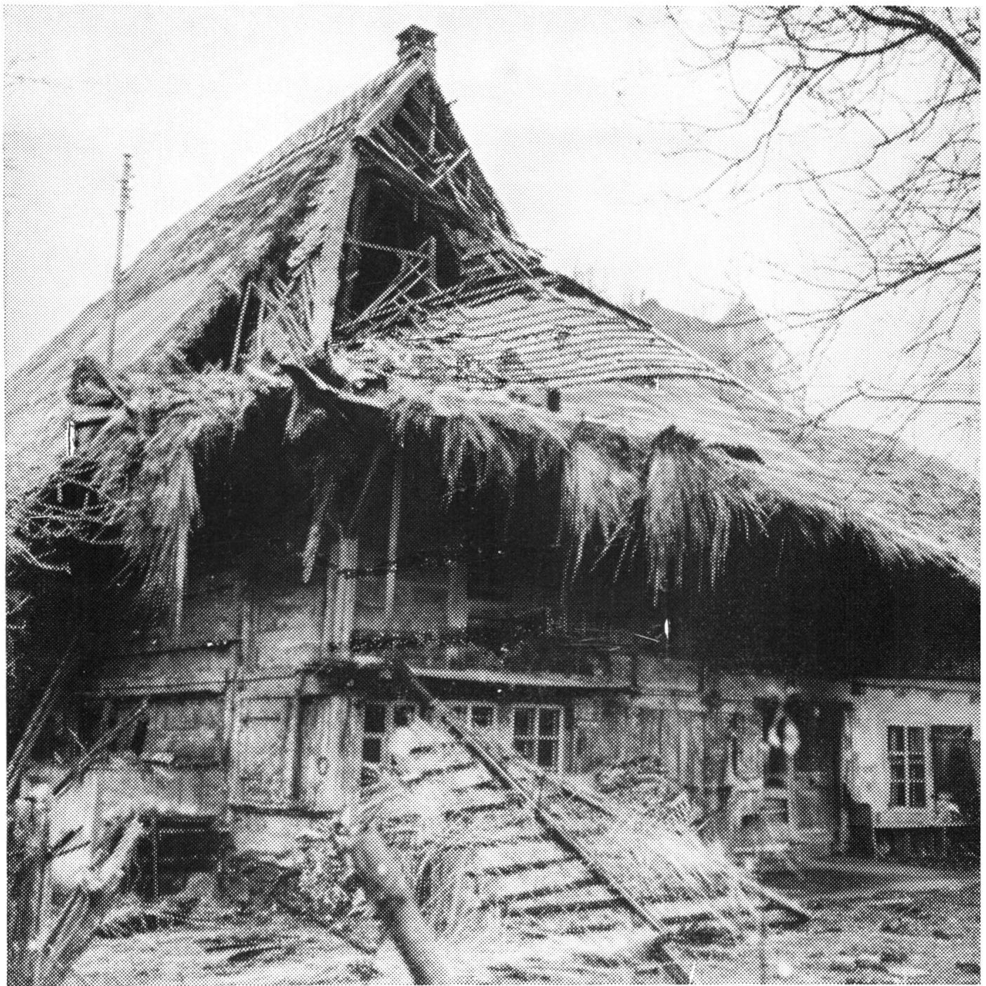
Das Lenzburger Strohhhaus kurz vor dem Abbruch
