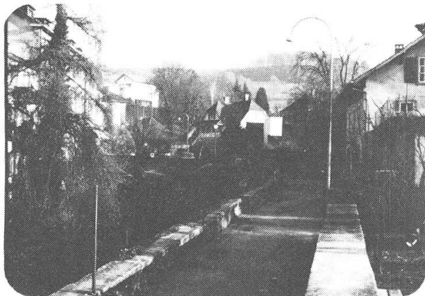
Abb. 37, Graben südlich der ur- sprünglichen Ringmauer
