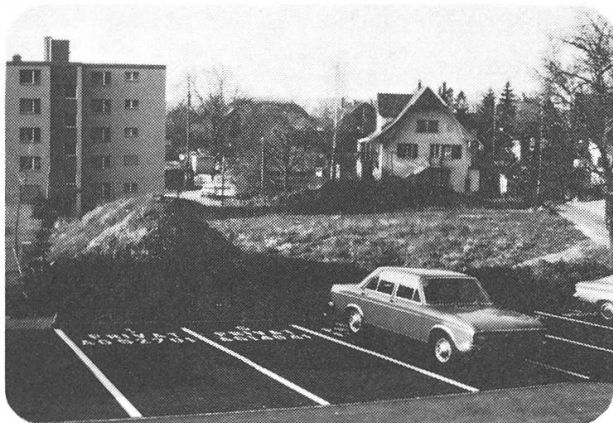
Abb. 33, Ensemble Burghalde von Osten
