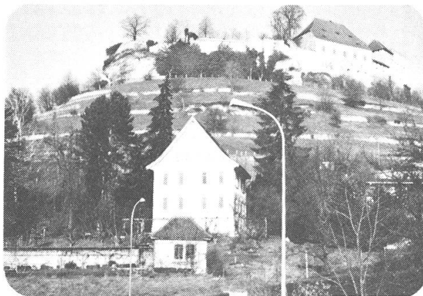
Abb. 46, Beispiel eines die Sichtbeziehung störenden Elementes
