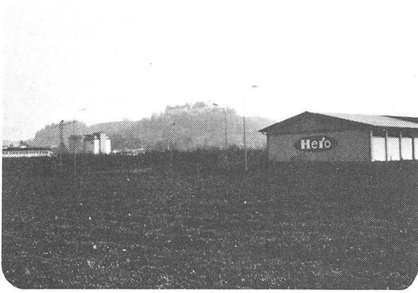
Abb. 59, Gebiet Nähe Autobahn 1975
