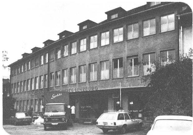
Abb. 78, Beispiel einer Zusammenlegung mehrerer ursprünglich vorhandener Gebäudeabschnitte
