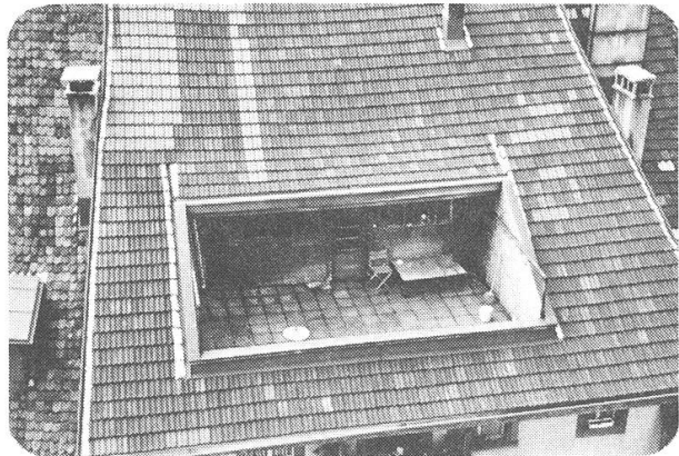
Abb. 101, Gegen die Regel verstossender neuerer Dacheinschnitt (Brättligäu)
