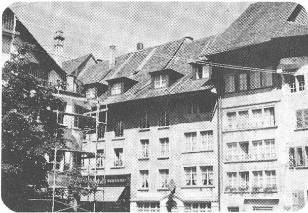
Abb. 100, Neuere Dachaufbauten (Leuengasse)
