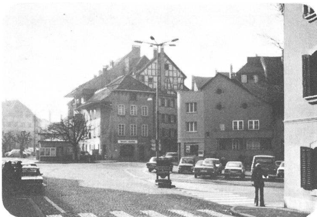
Abb. 113, Erfassung des Kronenplatzes als nicht definierter, unattraktiv gestalteter Raum mit stilfremden Gebäudeelementen an exponierter Stelle (Eckgestaltung, Flachdach)
