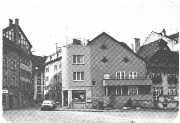
Abb. 114, Zugang Rathausgasse geht auf die Unterbrechung der Hufeisenform in der Zeit vor 1624 zurück. Die stilfremden Elemente wirken an dieser exponierten Stelle stark störend
