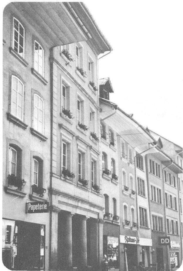
Abb. 130, Als Einzelelemente ablesbare Fenster; Rücksprung im Erdgeschoss als Ausnahme bei öffentlichem Gebäude (Altes Amtshaus)
