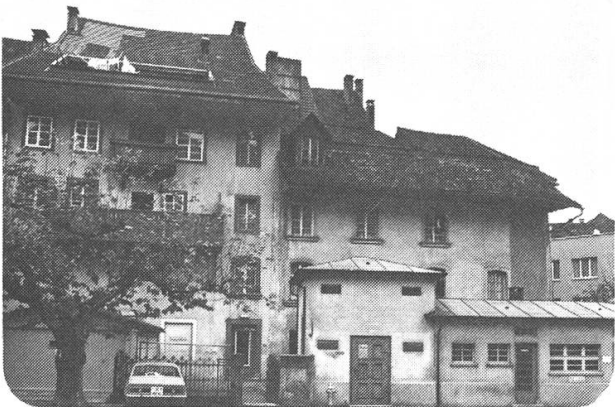
Abb. 150, Stadteigene, abbruchwürdige Vorbauten im Brättligäu
