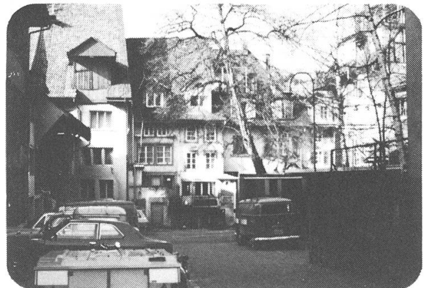
Abb. 183, Störende Ein- und Anbauten an den Rückfassaden der Häuserzeile an der Kirchgasse
