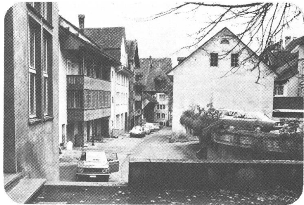
Abb. 182, Häuserzeile Oberer Scheunenweg links, störende Bauten rechts
