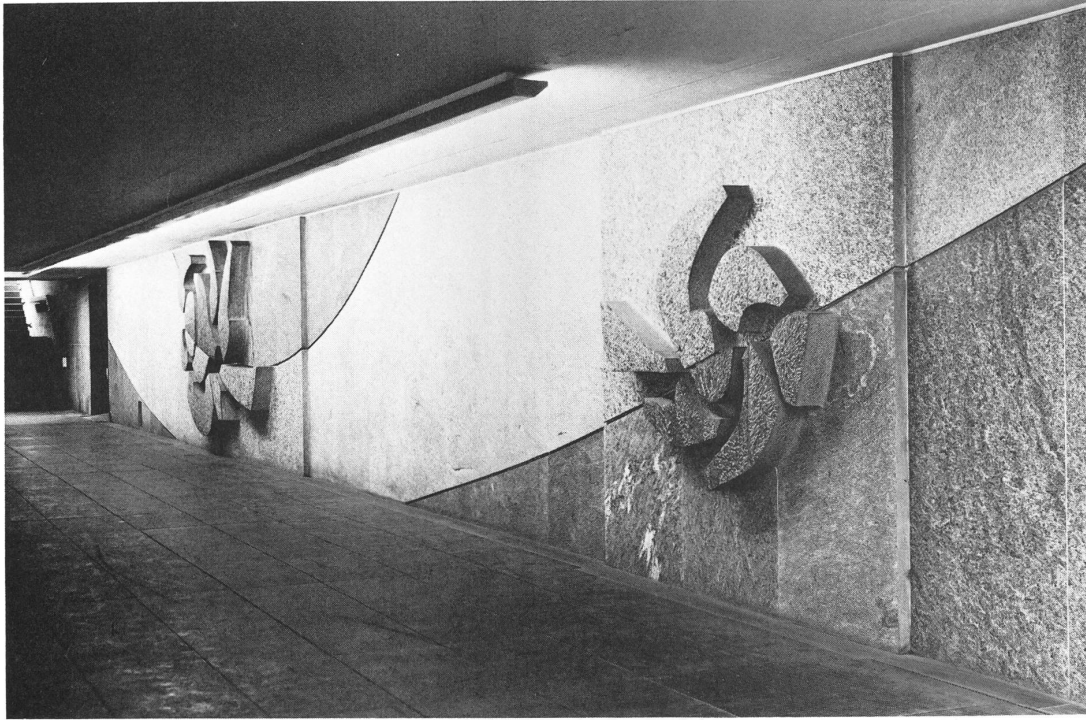
Wandgestaltung, Granit, Unterführung Bahnhofplatz Aarau, 1967
