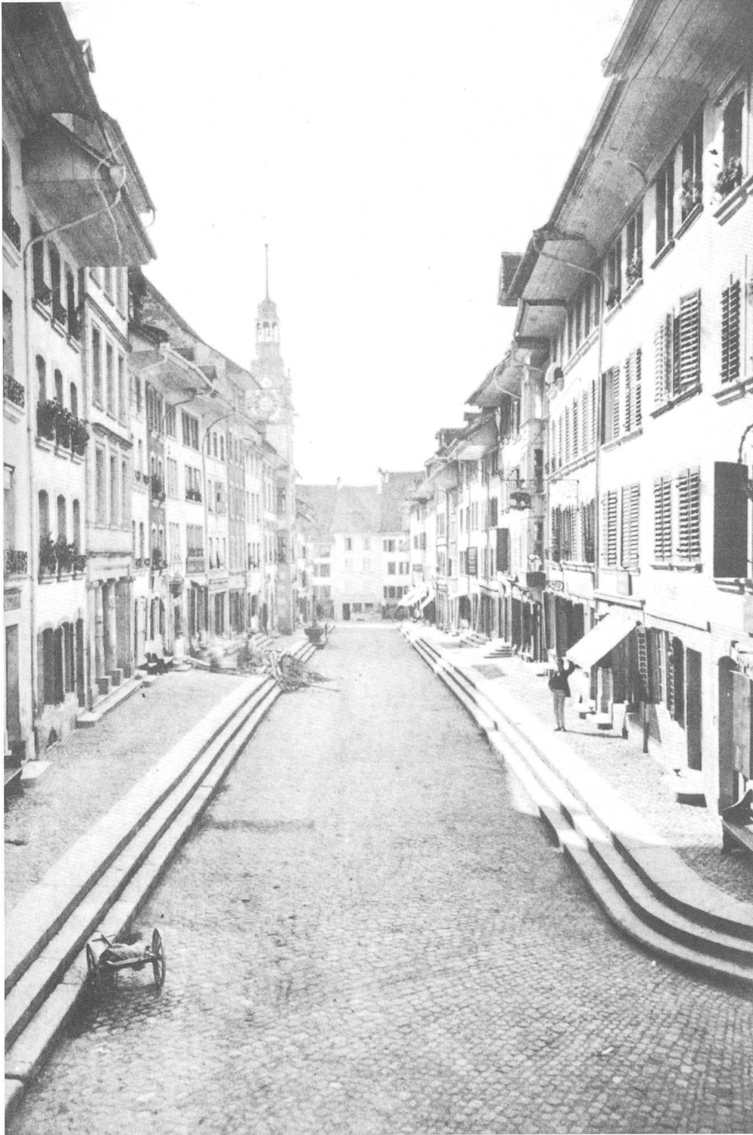
Die Rathausgasse nach der Tieferlegung und vor dem Bau des «Durchbruches» (er wurde aus Anlass des kantonalen Schützenfestes 1911 erstellt).
