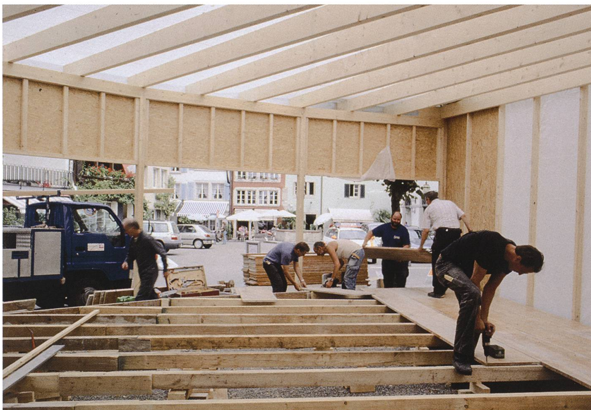
Bau der Festbeiz «zum Tintefass» am Metzgerplatz
