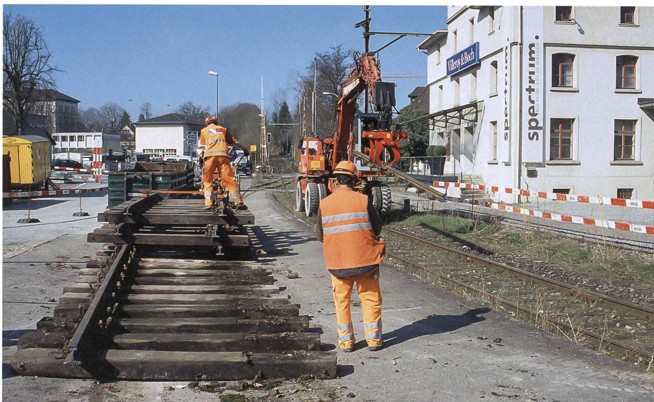
Gleisabbruch beim ehemaligen Stadtbahnhof. Foto: Bre.
