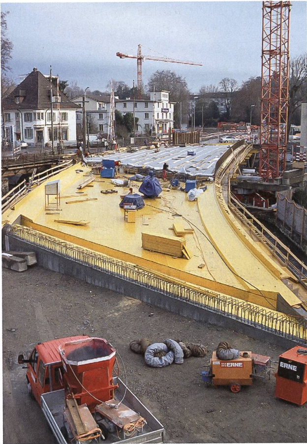
Baustelle Kernumfahrung Aabachbrücke.
