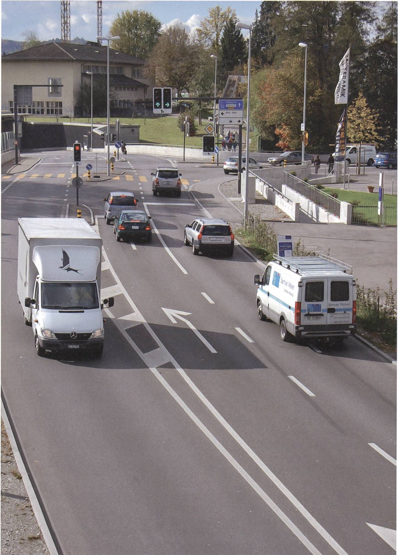
Knoten Seetalplatz mit Personenunterführung und Lichtsignalanlage. Foto: HH.
