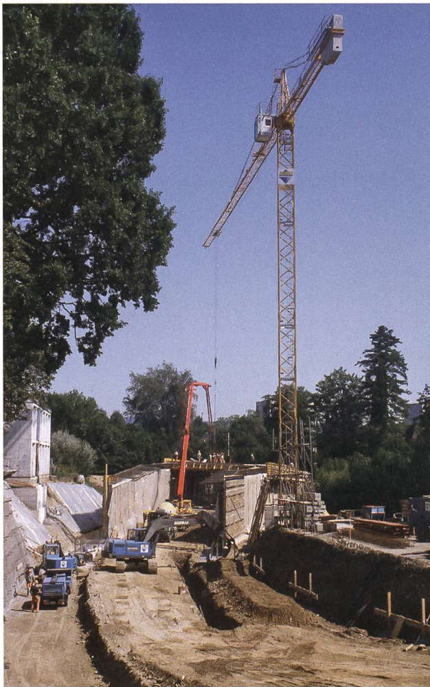
Betonpumpe beim Betonieren des Nordportals des Angelraintunnels. Foto: Bre.
