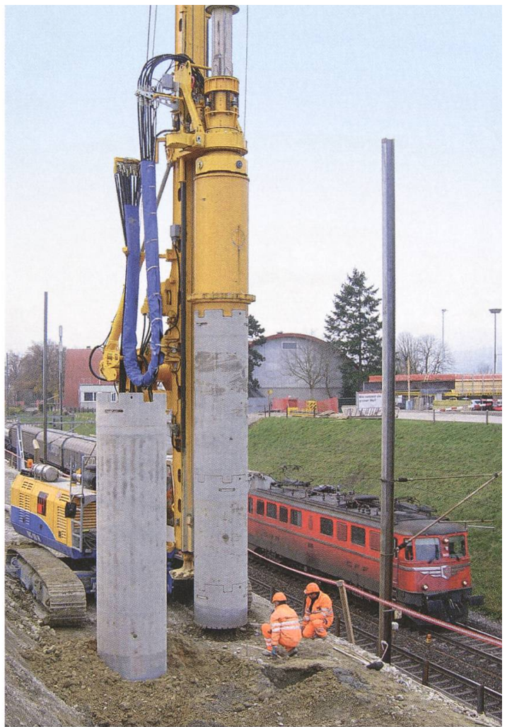
Erstellen der Bohrpfähle für die Pfahlwand
