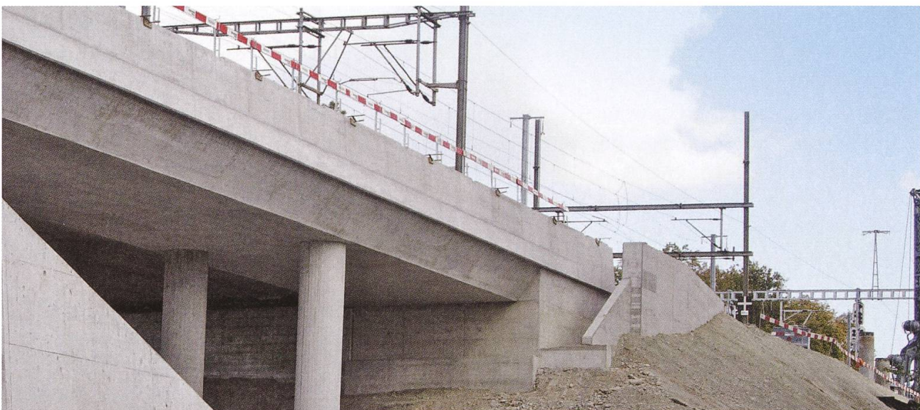
Fertiggestellte zusätzliche Brücke über die Niederlenzerstrasse mit anschliessendem Damm
