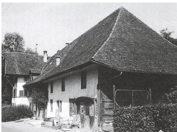
Die Scheune vor dem Umbau 1983 zur Urgeschichtswerkstatt. Foto: Armin Nussbaum
