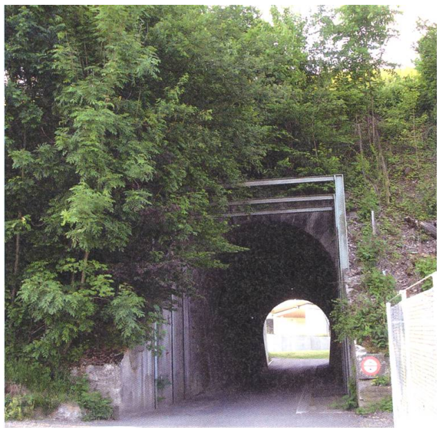
Der Seetalbahn-Tunnel wird saniert.
