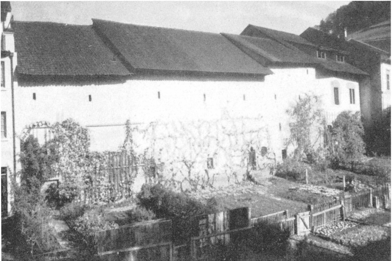
Die Ringmauer und der Graben wie sie sich anno 1903 präsentierten.
