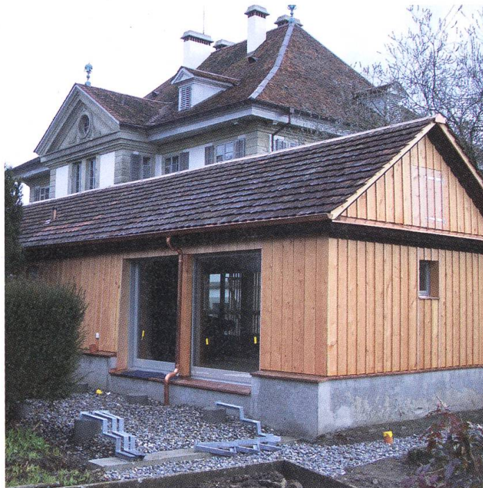
Im umgebauten, ehemaligen Gartenhaus residieren Writers in residence.
