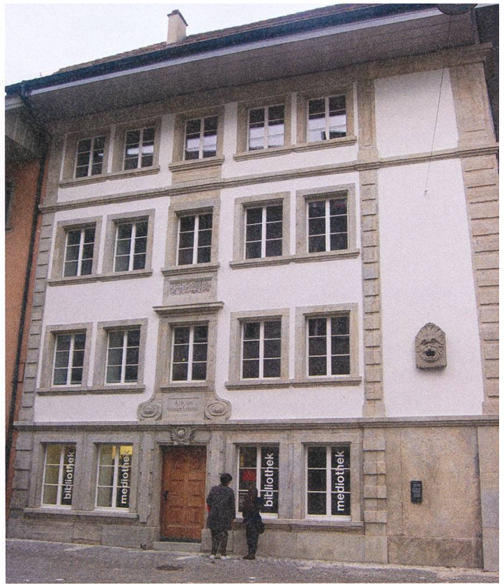
Nach der Sanierung erstrahlt der alte Spittel in neuem Glanz. Foto HH.
