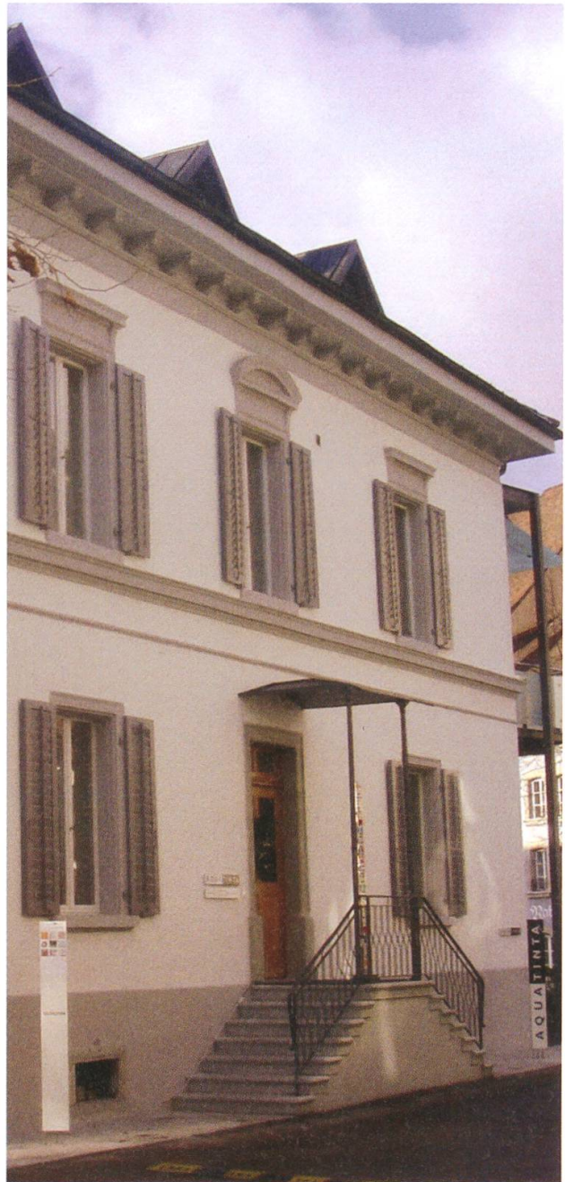
Die Galerie Aquatinta am Stadtgässli 2 steht seit Frühling 2014 leer. Foto HH.
