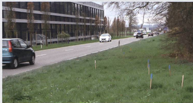
An der Aarauerstrasse vis-à-vis der Stiftung für Behinderte entsteht eine Bushaltestelle. Foto TF
