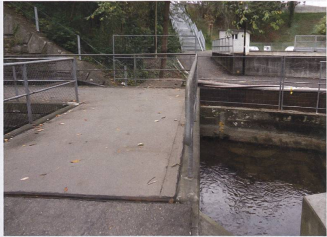
Der Steg wird wesentlich verbreitert. Foto TF
