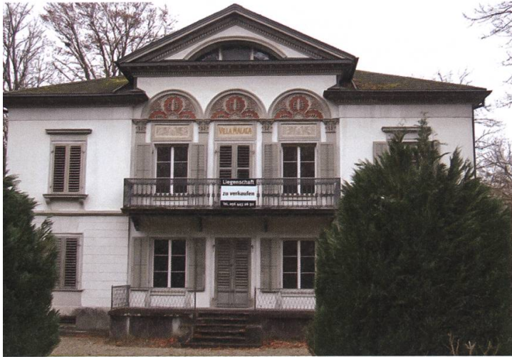
Die Villa Malaga an der Schützenmattstrasse steht seit längerem leer und zum Verkauf. Foto HH.
