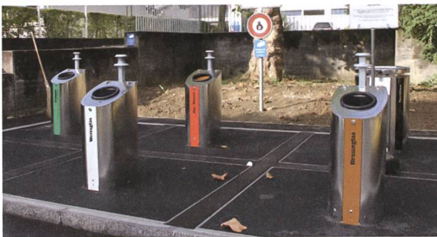
Die Unterflursammelstelle im Lenzhard. Foto AG
