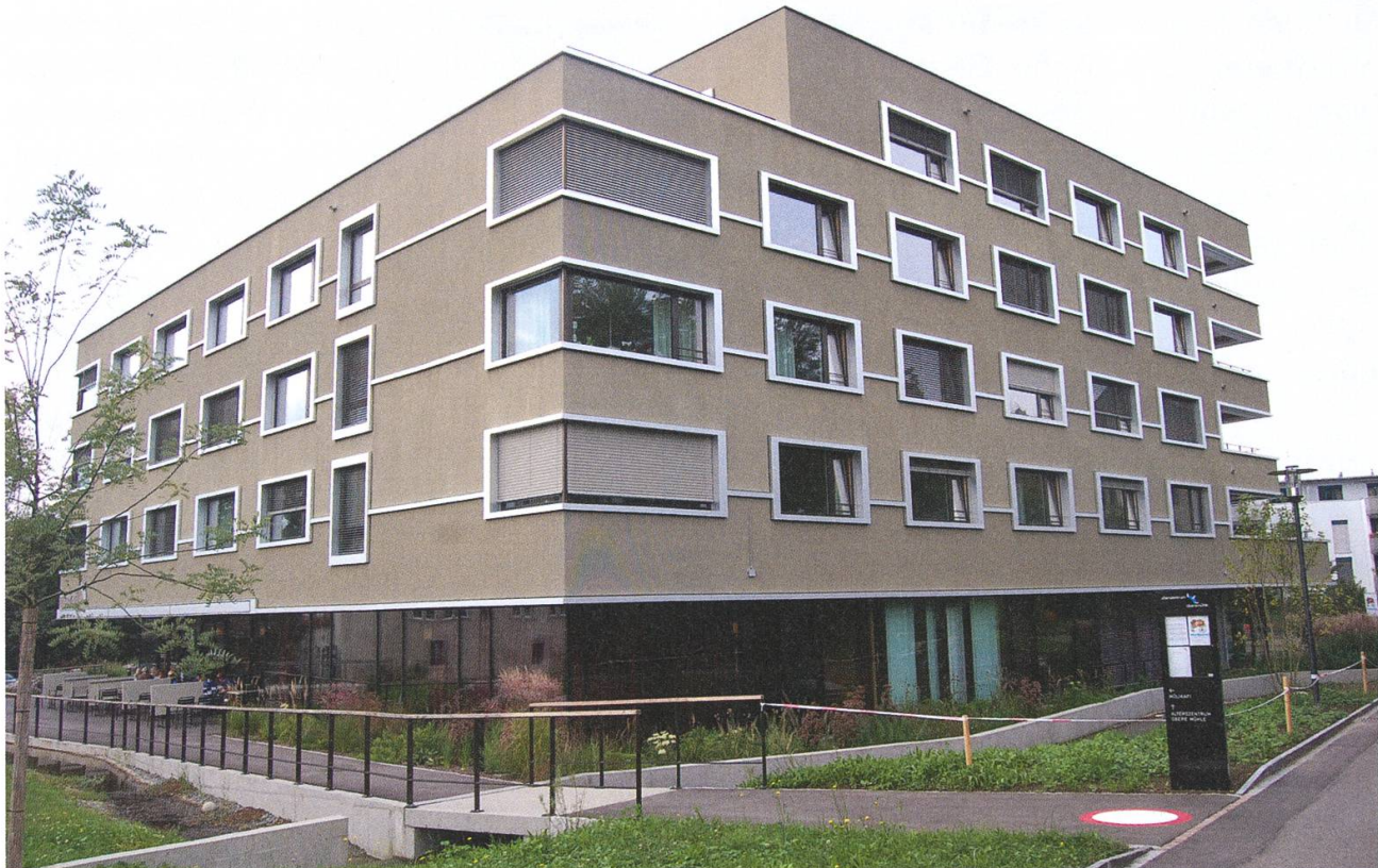
Die vielfältige Ausrichtung der Fassaden bewirkt ein Wechselspiel mit den umliegenden Gebäuden.
