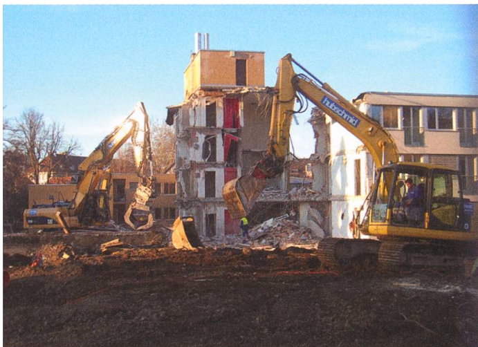
Der Altbau wurde Ende 2013 abgebrochen.
