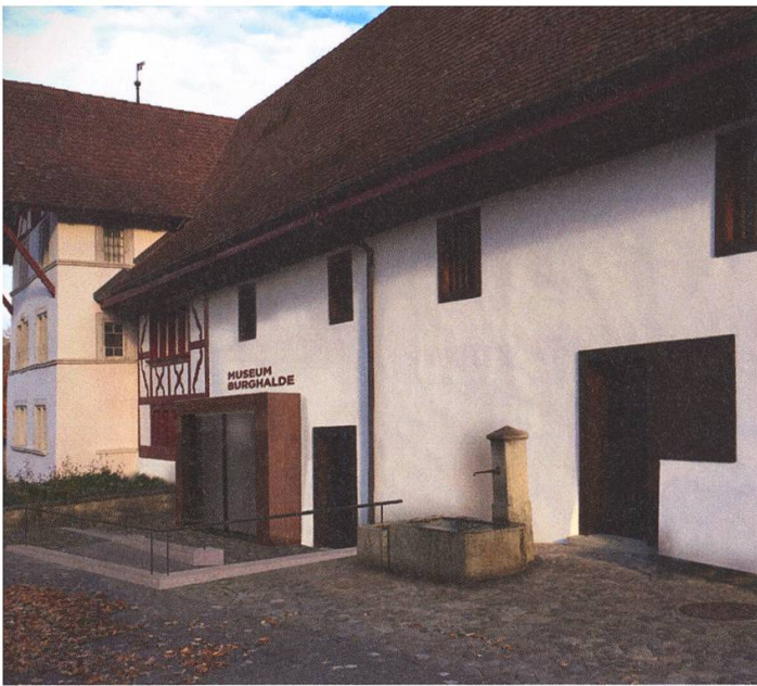
Der neue Eingangsbereich wird seitwärts zum ehemaligen Scheunentor verlegt. Foto MBL
