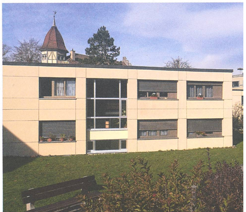
Obere Mühle: hier entstehen neue Alterswohnungen FT
