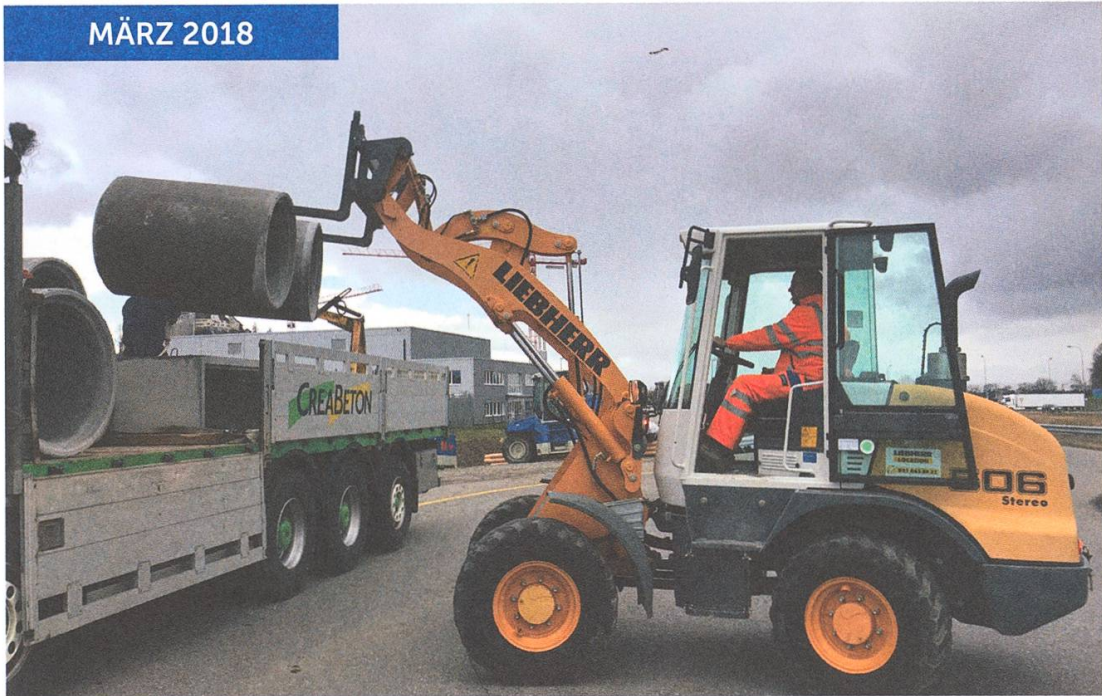
Erste Bau-Vorbereitungen beim Knoten Neuhof JG
