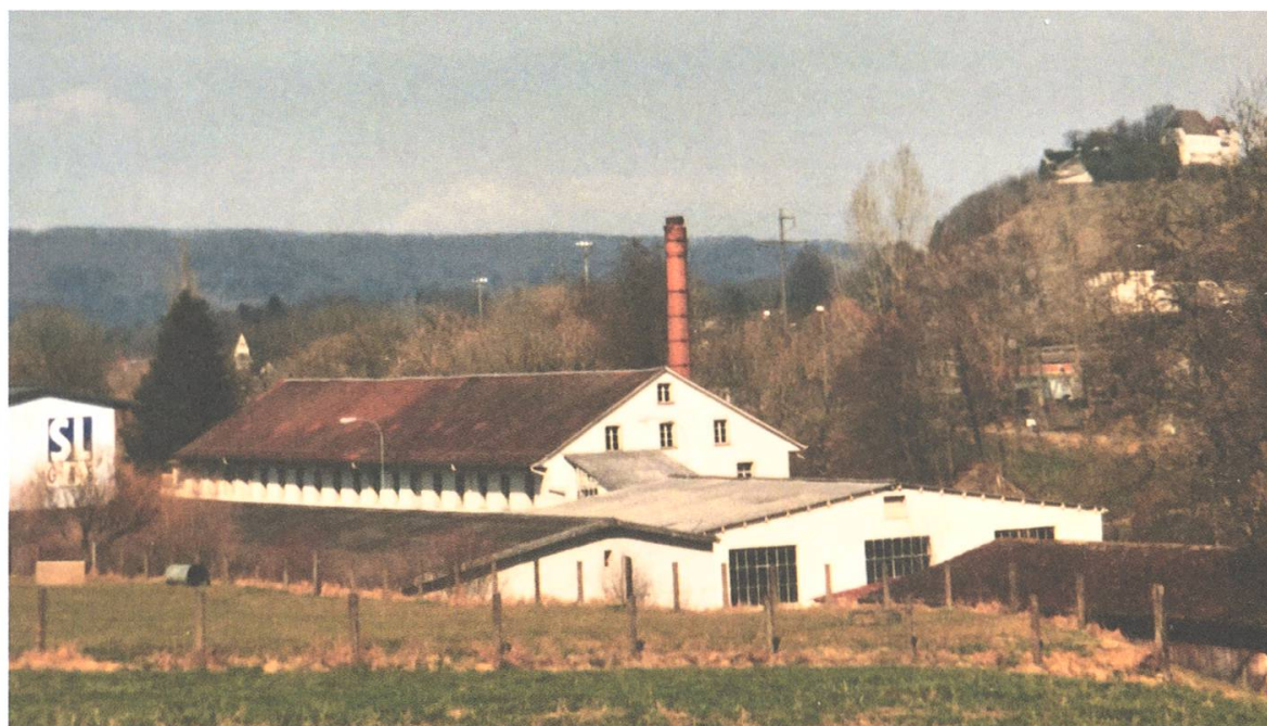
Kartonfabrik nach der Schliessung 1996 KB
