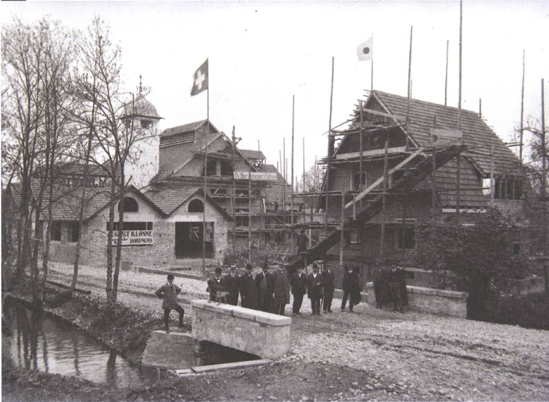
Das Bauunternehmen Theodor Bertschinger Söhne errichtet das neue Gaswerk © Museum Burghalde Lenzburg / SWL Energie AG
