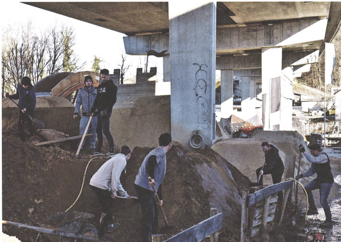
Umbau des Dirt-Jump-Parcours im Lenzburger Hammerpark T1
