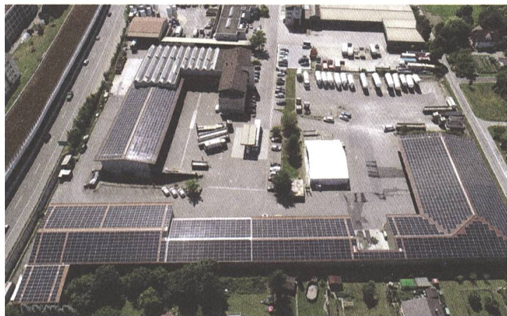
2391 Solarpanels auf den Dächern der Transportfirma Häfeli AG
