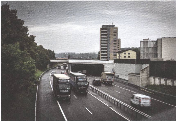
Auch das A1-Teilstück in Lenzburg wird auf sechs Spuren ausgebaut C1
