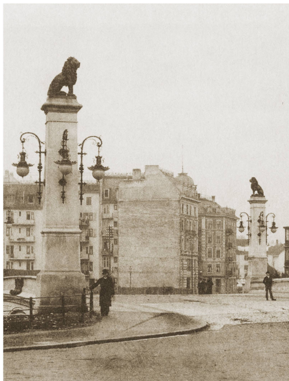
Aujourd'hui encore, les lions d'Eggenschwyler gardent le pont Stauffacherbrücke.
