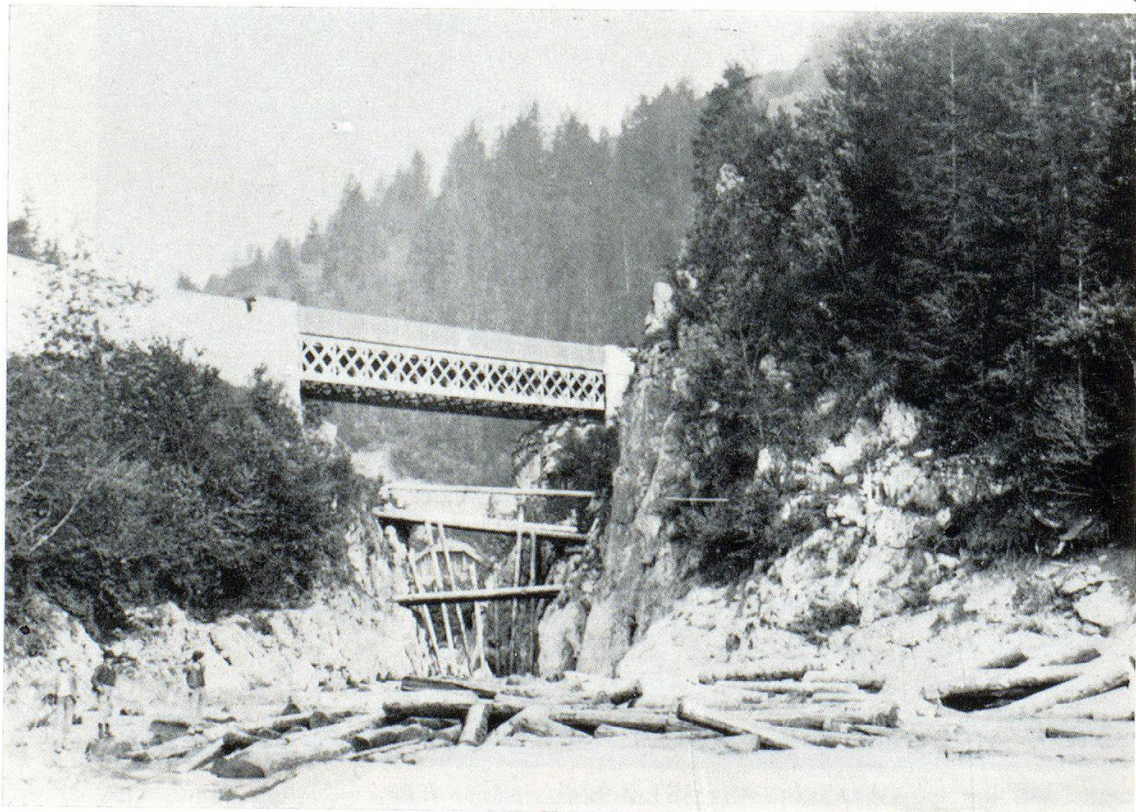
Abb. 12 a. Auffangrechen in der Saane ob der «Chaudanne»-Schlucht. Ende 19. Jh.
