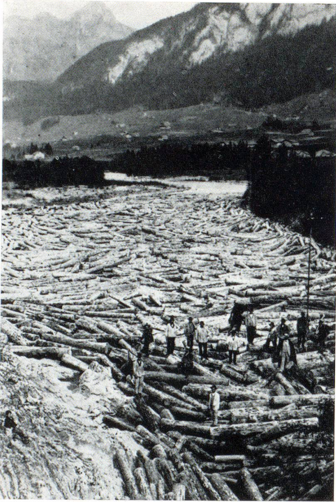
Abb. 12 a. Auffangrechen in der Saane ob der «Chaudanne»-Schlucht. Ende 19. Jh.
