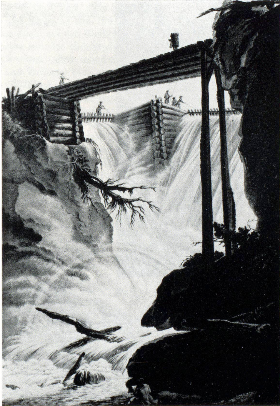
Abb. 11. Schwellenwerk im Gadmenwässer, errichtet 1770. Kolorierter Stich von WOLF DECURTINS 1775.
