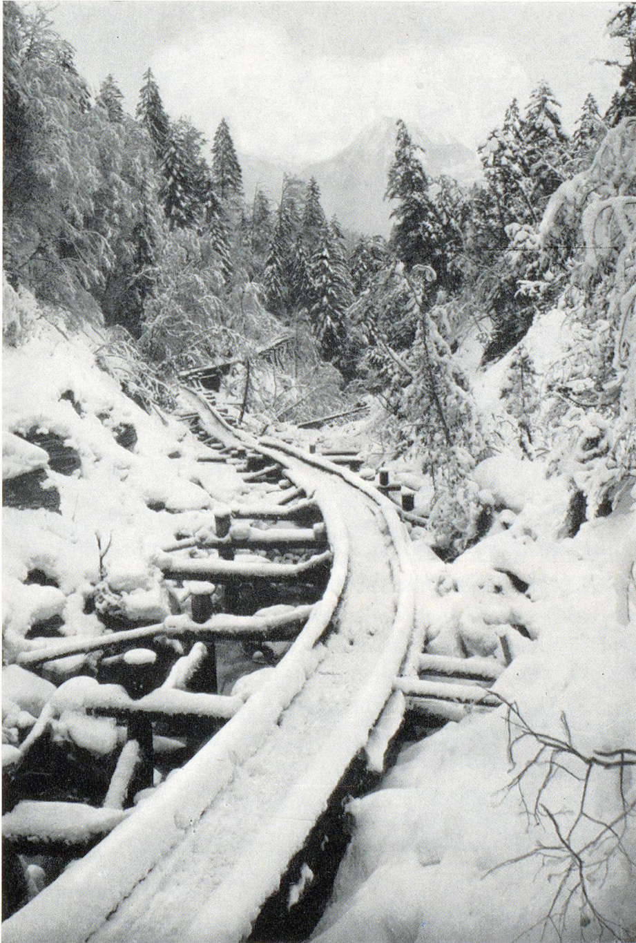
Abb. 17. Die kunstvoll gebaute Holzriese am Hang und im Einschnitt im Schlierental OW.
