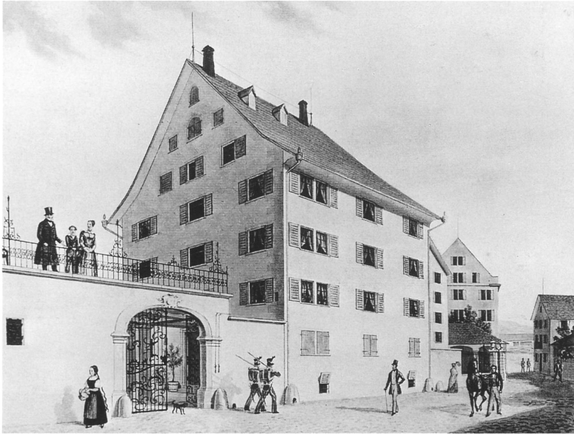
Abb. 39: Das Haus zum grossen Baumwollenhof in Stadelhofen, 1847 (Joseph Martignoni). Noch der biedermeierliche Baumwollenhof atmet die Grosszügigkeit des Ensembles, wie es um die Mitte des 17. Jahrhunderts entstand. Das traufständige, mehrgeschossige Wohnhaus bildet Zentrum und Kern der durch die Hofmauer von der Öffentlichkeit abgetrennten, gewerblichen und häuslichen Nebenbauten wie etwa Seidenmühle, Waschhaus und Scheune (Zentralbibliothek Zürich/Kdm).
