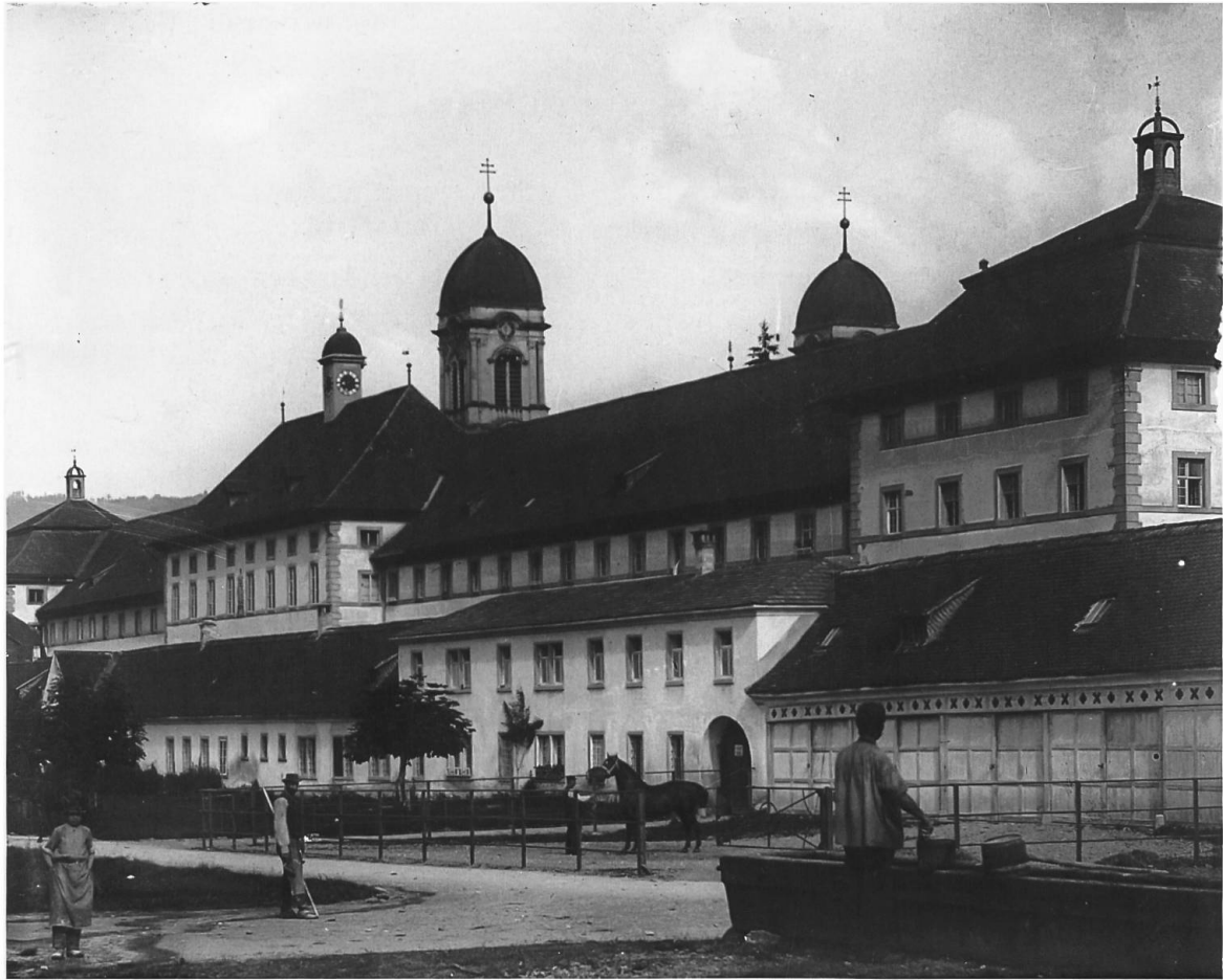
Die Arbeitsräume des neuen Archivs und der Musikbibliothek werden im Gebäude der alten Schreineri (im Vordergrund) untergebracht. (Klosterarchiv Einsiedeln, Glasplatte 05972)
