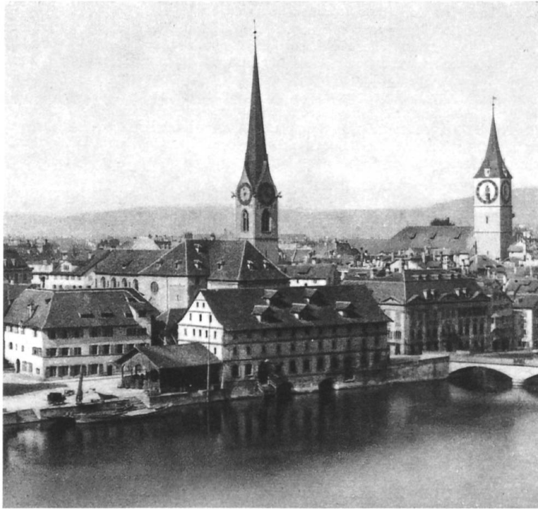
Abb. 5: Das Fraumünster nach seiner teilweisen Freilegung, links anschliessend das Stadthaus (Architekt Gustav Gull, 1898), Aufnahme 1901.
