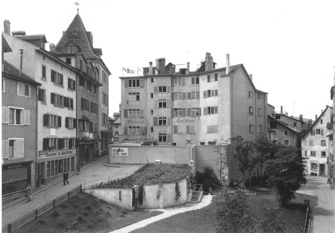
Abb.38: «Aus kernung» Spiegel-/Leuengasse (1938/39), Ansicht der neu entstandenen Freifläche nach den Abbrucharbeiten, Aufnahme um 1940.
