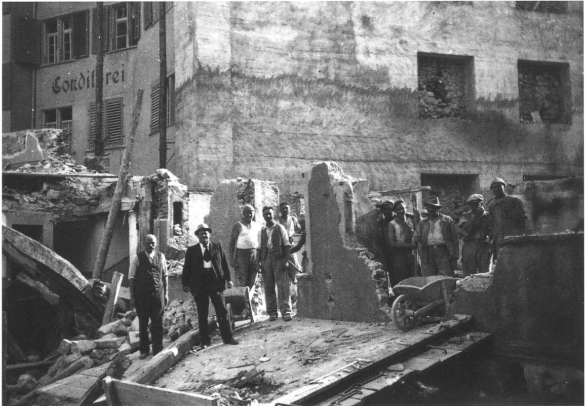
Abb.37: «Aus kernung» Spiegel-/Leuengasse, Abbruch der «Elenden Herberge» (Leuengasse 10), 1938.
