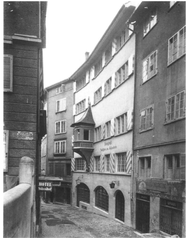
Abb.49: Stüssihofstatt 3, Haus «zum Königstuhl» (Architekt Alfred Nüsseler, 1938/39). Der Neubau mit dem vom Vorgängerbau übernommenen spätgotischen Erker, Aufnahme 1939.
