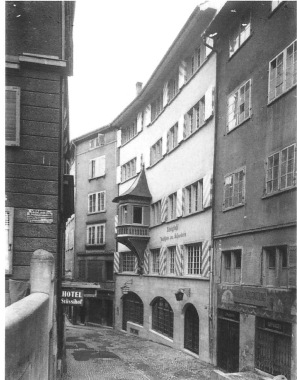
Abb.49: Stüssihofstatt 3, Haus «zum Königstuhl» (Architekt Alfred Nüsseler, 1938/39). Der Neubau mit dem vom Vorgängerbau übernommenen spätgotischen Erker, Aufnahme 1939.
