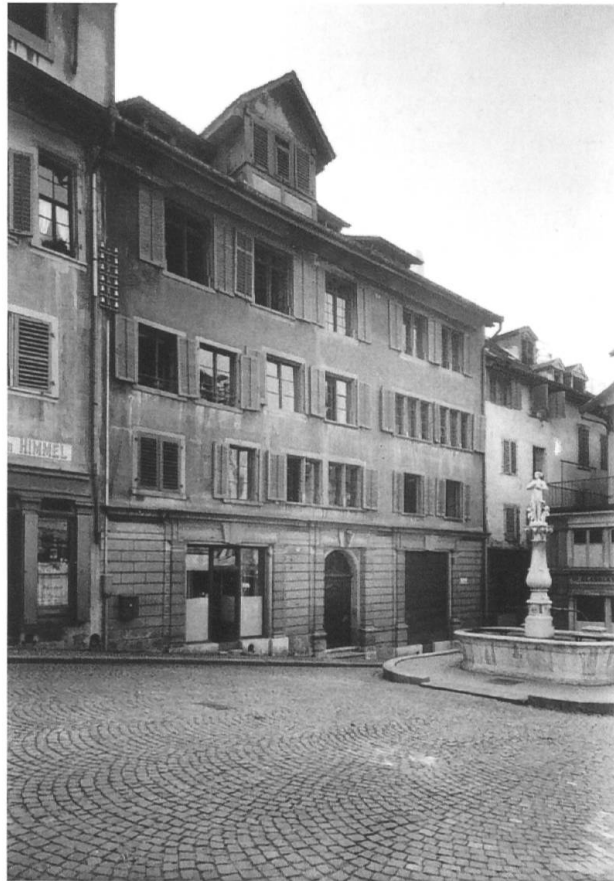
Abb.57/58: Haus «zum Napf» (Napf- gasse 6) vor (oben) und nach der Restau- rierung durch Architekt Max Lüthi, 1944 (unten).
