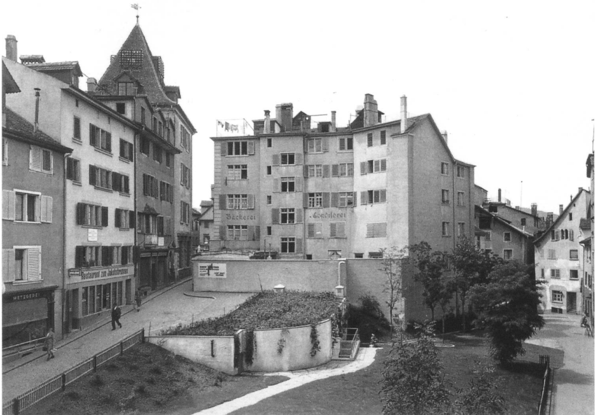
Abb.38: «Aus kernung» Spiegel-/Leuengasse (1938/39), Ansicht der neu entstandenen Freifläche nach den Abbrucharbeiten, Aufnahme um 1940.
