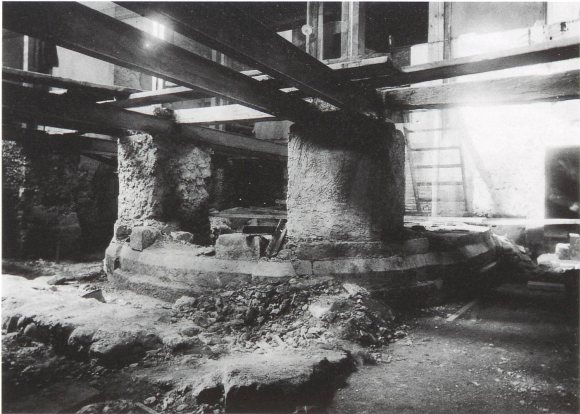
Abb. 5: Blick in den Chor während des Einbaus des Unterrichtszimmers um 1900. Von der hufeisenförmigen Mauer der Aussenkrypta aus dem 11. Jahrhundert sind erst drei Steinlagen freigelegt. Darauf stehen zwei massive Fundamente, auf denen die Stahlträger für den neuen Chorboden liegen. (Baugeschichtliches Archiv der Stadt Zürich)
