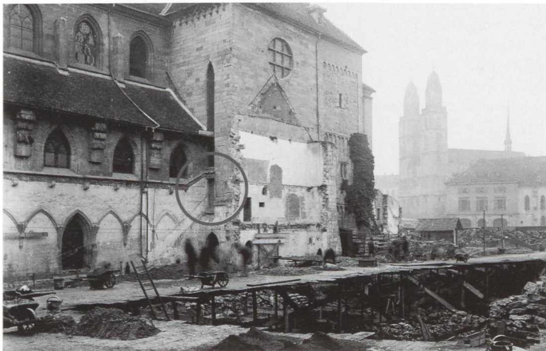
Abb. 3: Oben: Friedhof und Nordostecke des Kreuzgangs im 19. Jahrhundert. Einkreist ist die kleine Abdachung über dem einstigen Eingang bei den Seitenemporen. (Foto: Fraumünster-Archiv) Unten: Den gleichen Anblick bietet die Südseite der Kirche nach dem Abbruch der an das südliche Querschiff angebauten Abteigebäude (Aufnahme 1898). An der Kirchenwand sind Spuren des abgebrochenen Treppenaufgangs zu den Emporen deutlich sichtbar. Einkreist ist der einstige Eingang. (Foto: Robert Breiting, 23. November 1898, Baugeschichtliches Archiv der Stadt Zürich)
