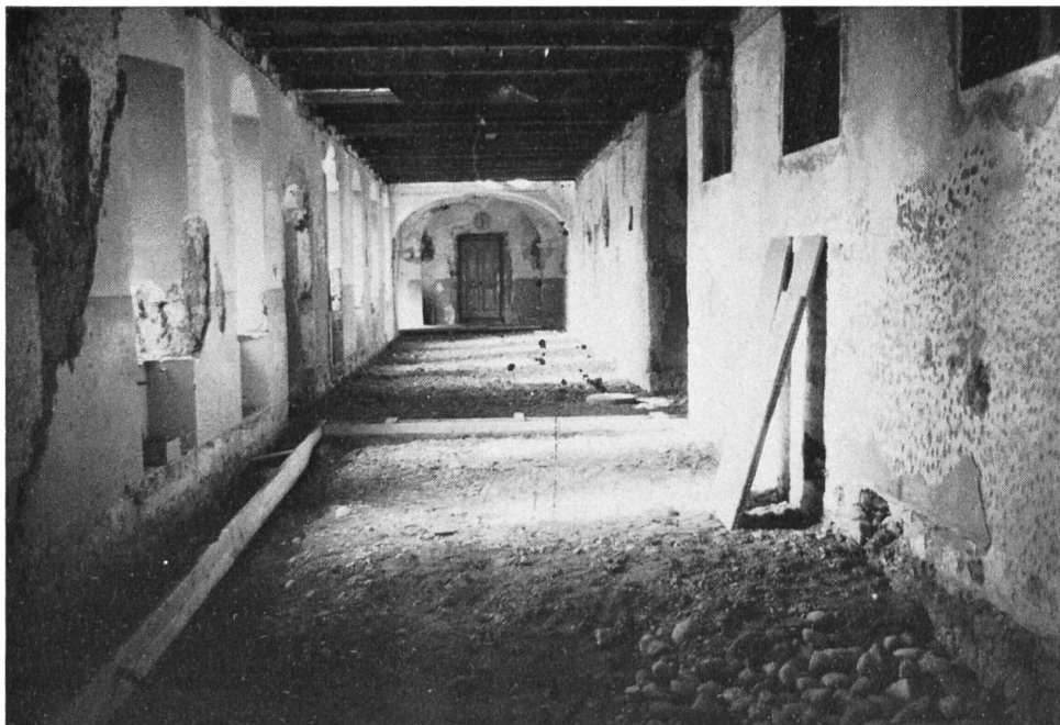
Konventstock, Erdgeschoss. Der Gang wurde trockengelegt und ist nun bereit, die Unterkonstruktion für den Bodenbelag aufzunehmen.
