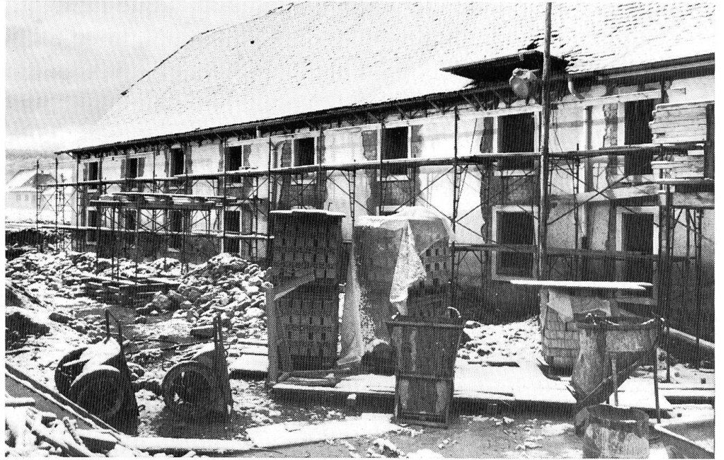
Altes Ökonomiegebäude, Südseite. Die Fenster für die neuen Zimmer werden eingebaut.
