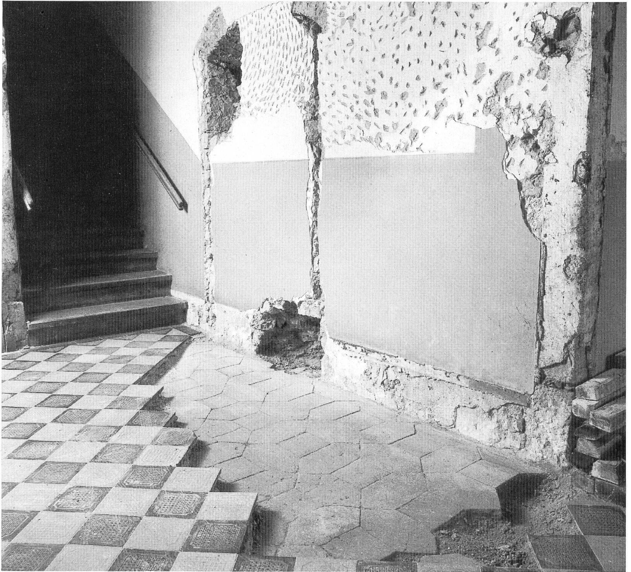
Konventstock, Gang Erdgeschoss. Treppenhaus- vorplatz. Unter dem Gips erscheinen der originale Verputz, unter den Zementplatten die alten, im Rosenspitz-Muster verlegten Tonplatten.
